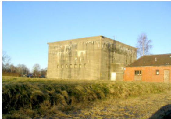
Südwestansicht des Bunkers
