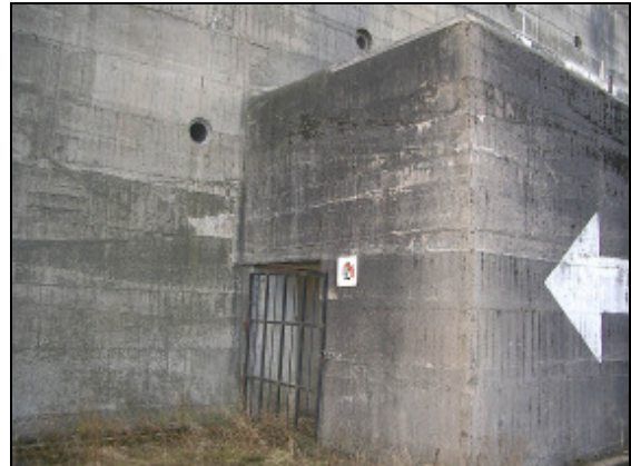
Noch heute ist ein Originalverschlussgitter am nördlichen Splitterschutzvorbau zu erkennen...
