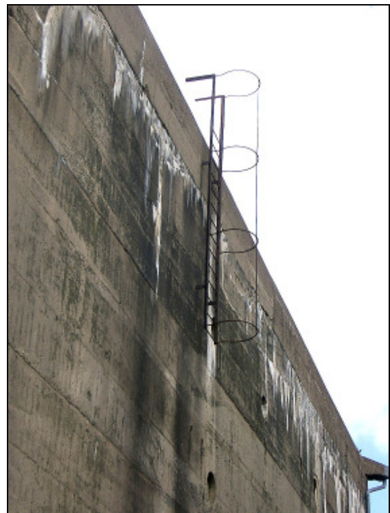
Der erhaltene Teil der südlichen Steigleiter oberhalb des Splitterschutzvorbaues
