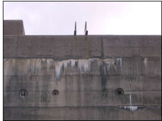
Reste der nördlichen Steigleiter
